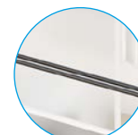
Potrubí s chladivem
